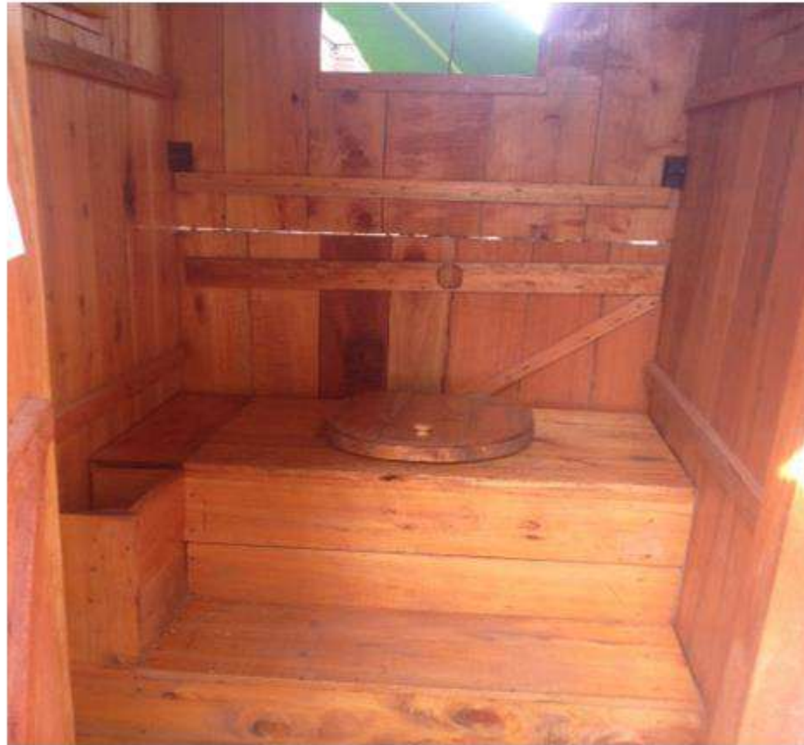
Vue intérieure d'une toilette sèche collective fabriquée localement
